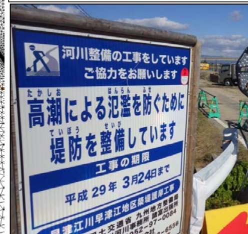
海岸堤防 整備中箇所
