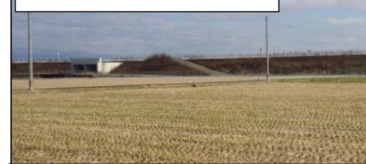
沿岸道路（盛土）
