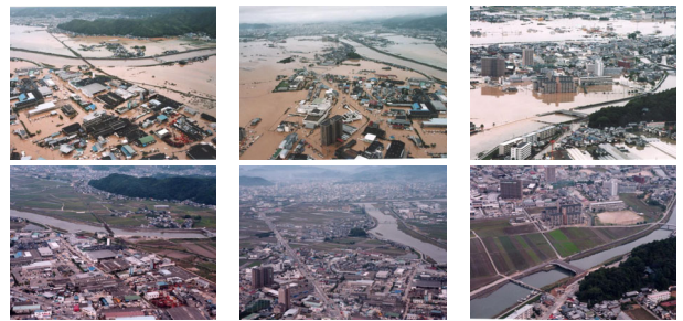
図6 国分川下流部の浸水、上:冠水時、下:復旧時(高知県警察)
